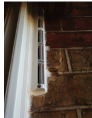
Vue de l'extérieur du logement
