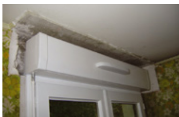
Bloc baie avant finition (doc. ESPACE9)
