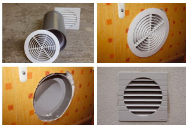
Traversées de mur acoustique (doc. ESPACE9)
