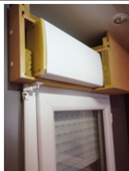
Surcoffre recouvrant l'ancien coffre PVC (doc. COFERMING)
