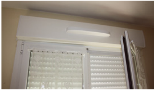
Technique n°1 : Coffres de volets roulants intégrés (doc. ESPACE9)
