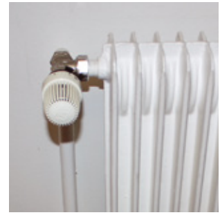
Emetteur muni d'un robinet thermostatique (doc. ESPACE9)
