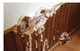
Dépôt de mэрule dans l'habitat intérieur (doc. ISOSEC)
