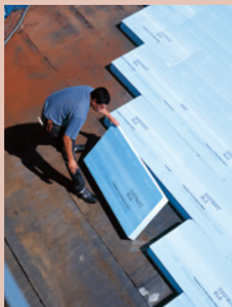
Polystyrène extrudé, PSX (doc. DOW)
